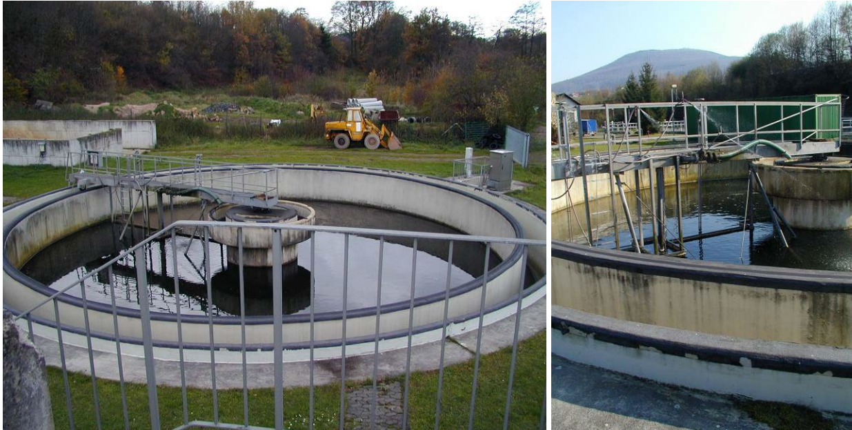
Abb. 6-5: Nachklärbecken der Kläranlage Tann/Rhön
