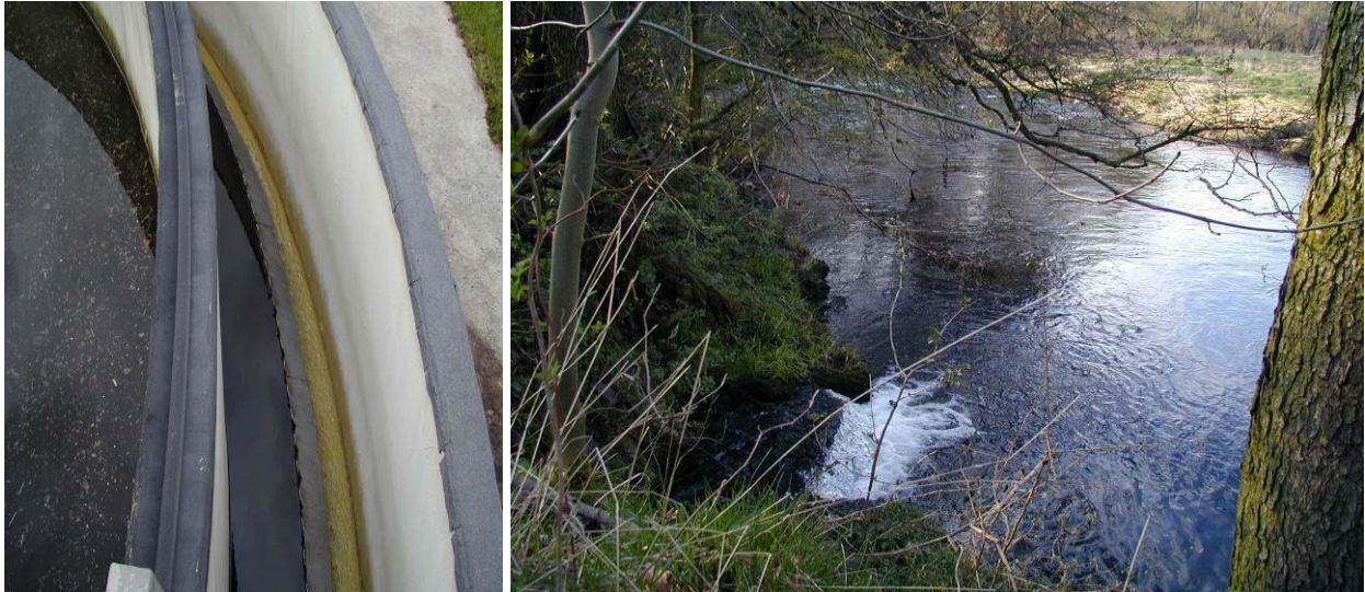
Abb. 6-8: Ablauf aus dem Nachklärbecken – Auslauf in die Ulster
