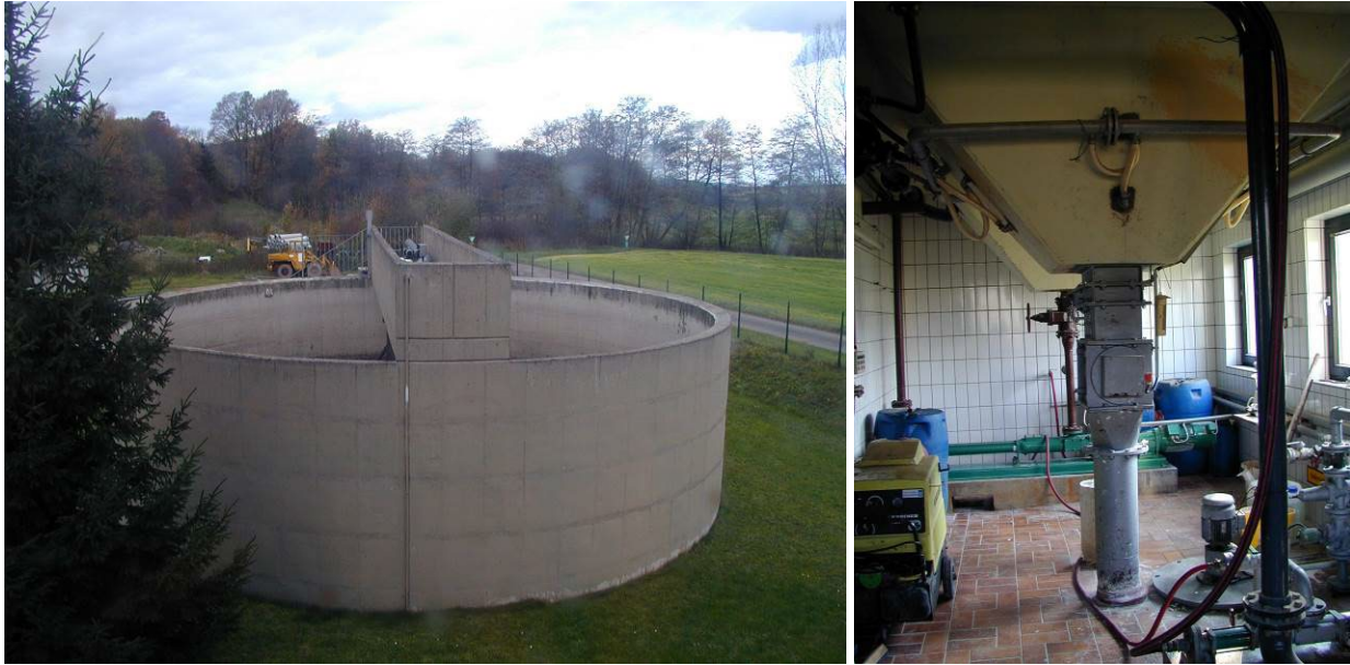
Abb. 6-6: Eindicker und Konditionierung der KA Tann/Rhön
